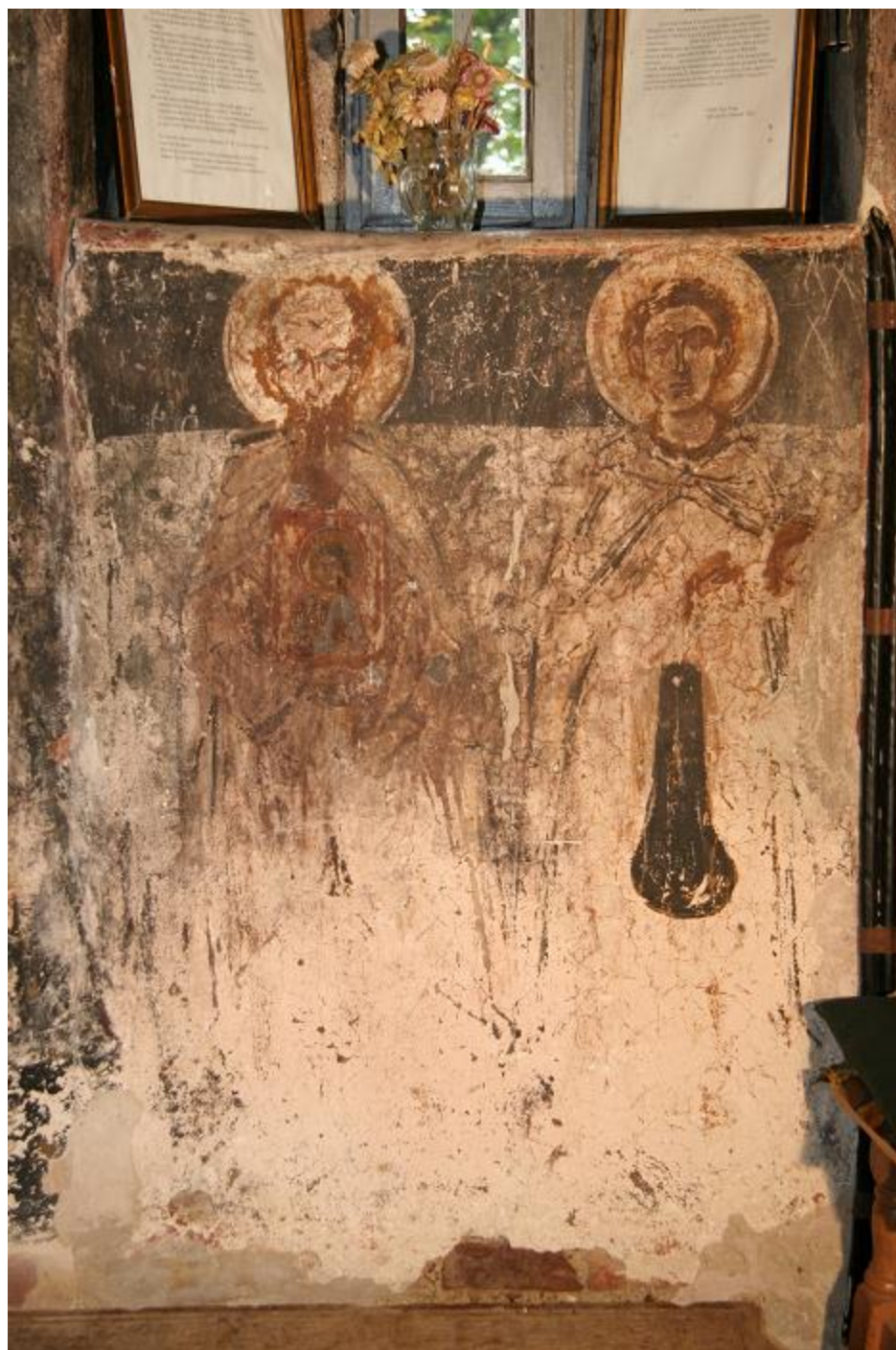
11. Două imagini de sfinți neidentificați pe suprafața peretelui de sub fereastra de sud
